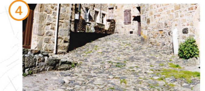
TAPIS CENTRAL : calade existante restaurée et complétée. Ajout de fil d'eau
