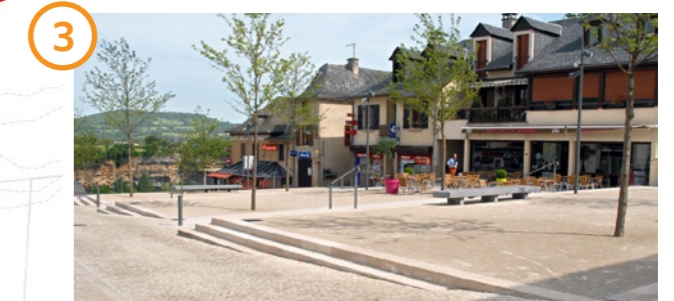
TERRASSES : emmarchement en pierre et socle en béton désactivé SPR
